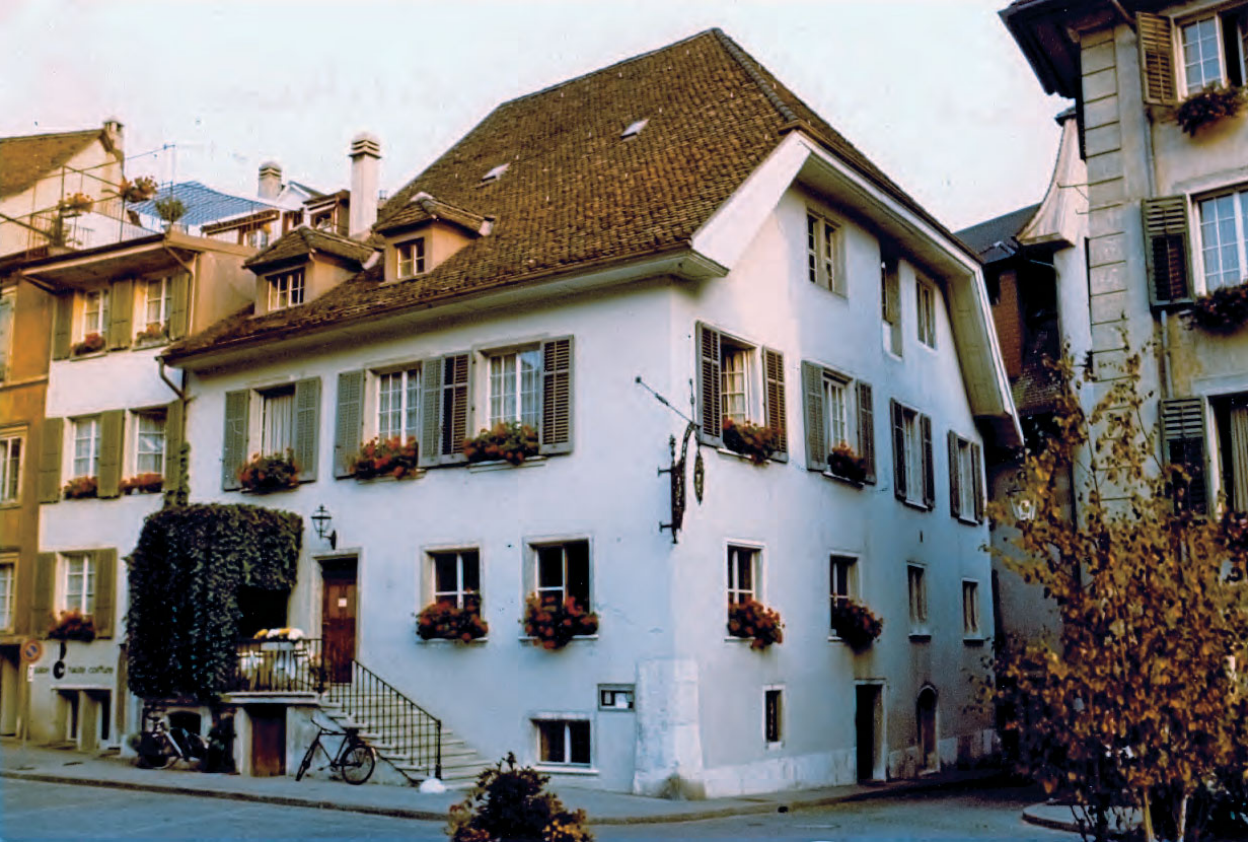
Erinnerung an frühere Zeiten: Misteli vor dem Umbau.
