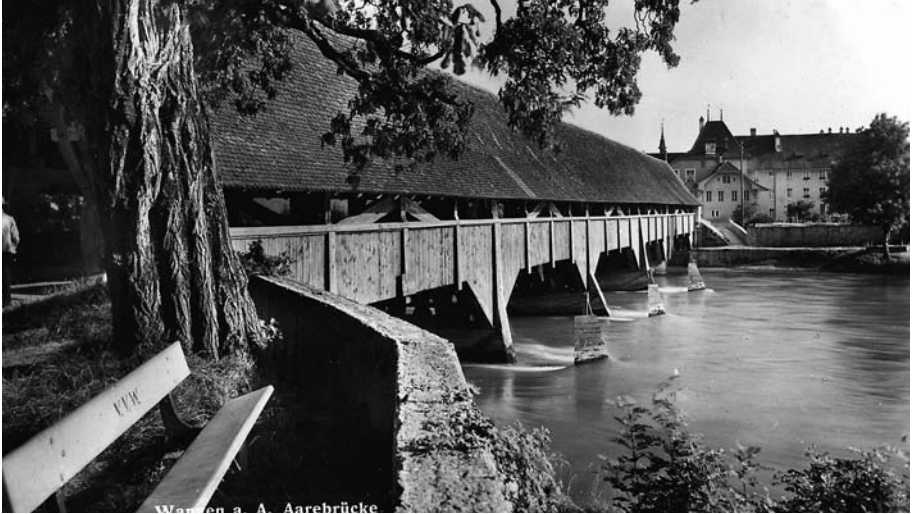
Wanger Holzbrücke im Zustand zwischen 1934 und 1967 (Aufnahme 1935)
